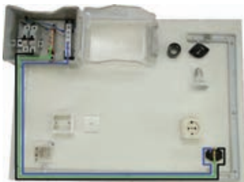
شکل ۵-۱۰- انجام سیم‌کشی پریز ۱
