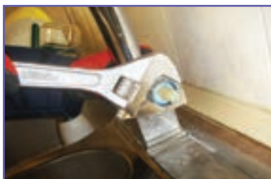
ث- باز کردن پیچ روی مغزی (گلند)
