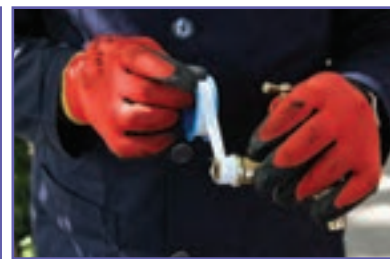
پ- پیچیدن نوار تفلون روی شیر نو
