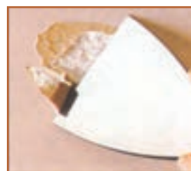
الف - باز کردن ترک‌ها
