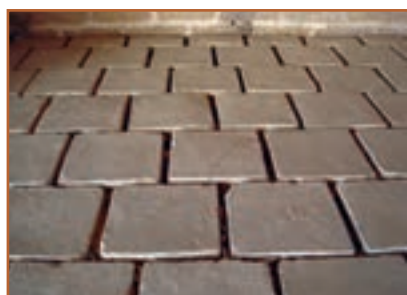
پ - استفاده از آجر برای کف
